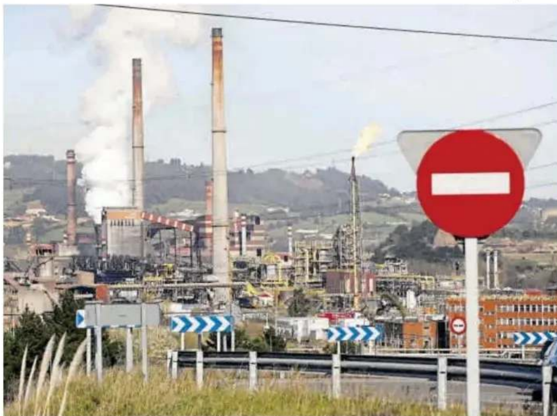
Fábrica de ArcelorMittal en Veriña (Gijón).
